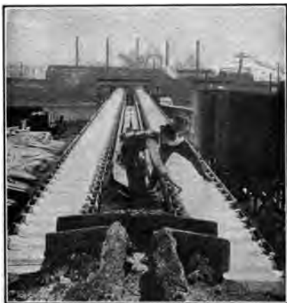
FIG. 123. — Casting pig iron.
